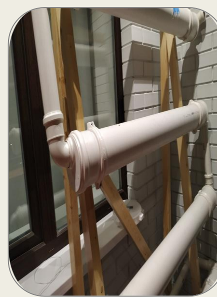
Отвод \varnothing 50 \times \varnothing 87 мм (уголок)
